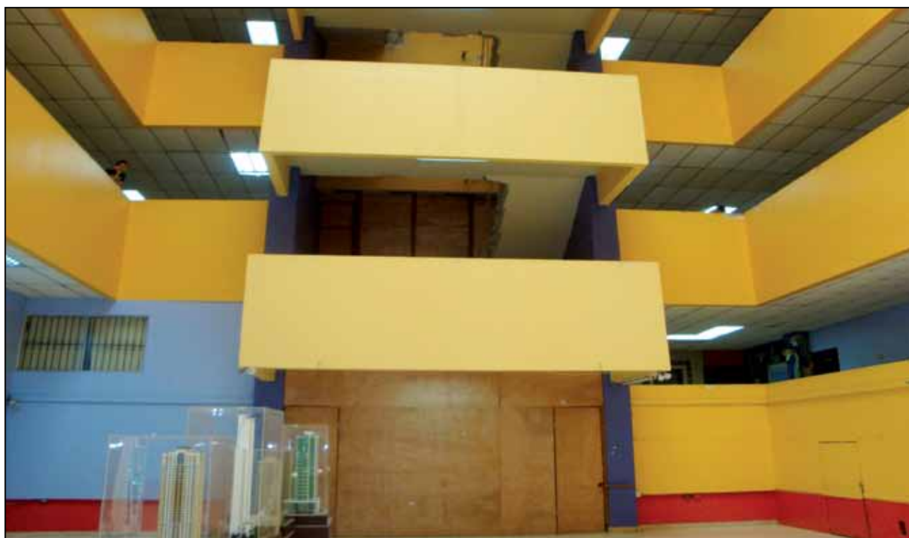
Vista de trabajo de obra civil para ascensor de la Facultad de Arquitectura.
