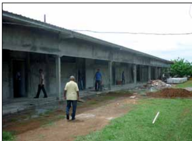
Vista del edificio de aulas de Cru de Azuero.
