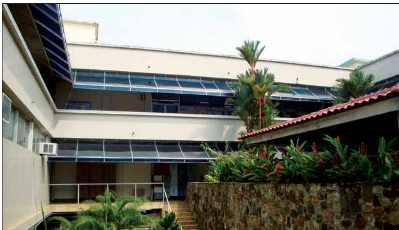
Vista de toda el área donde se reemplazó el alero de la Facultad de Odontología.
