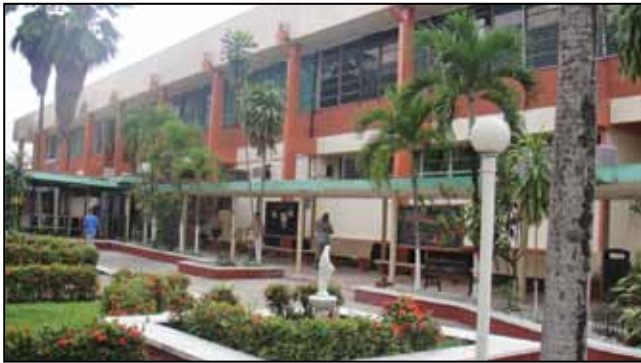
Restauración y pintura del edificio de Anatomía.
