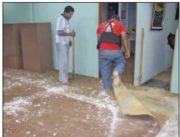
Remoción de la alfombra de las oficinas Administrativas.
