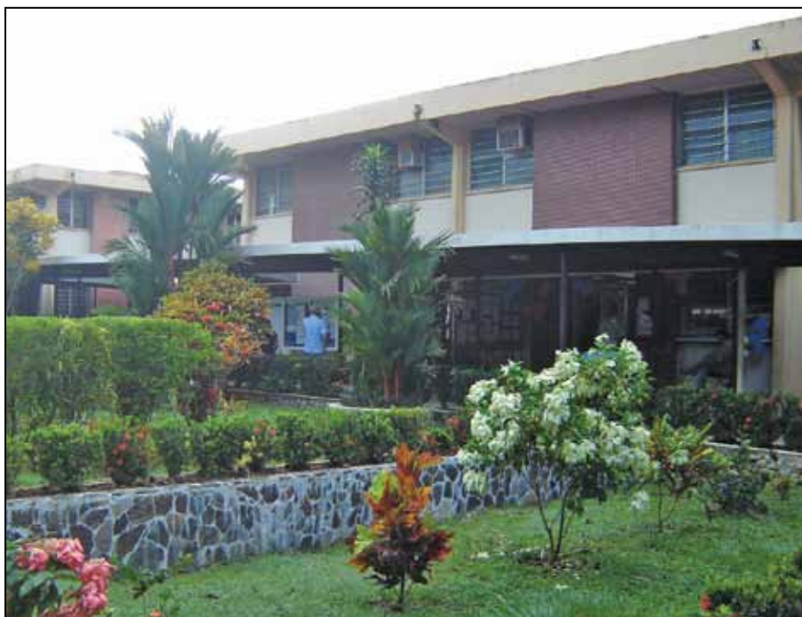
Edificio Administrativo Centro Regional Universitario de Veraguas.
