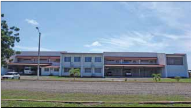
Instalaciones de la Extensión Universitaria de Aguadulce.
